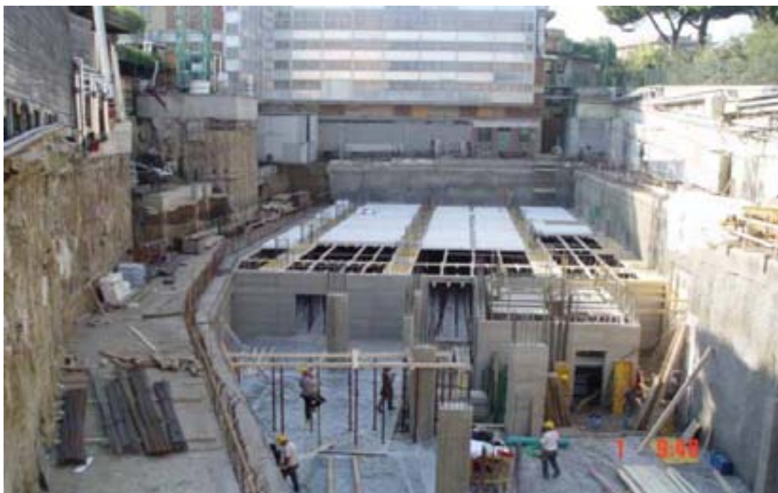
Fasi della costruzione del nuovo padiglione dell'Ospedale Pediatrico Bambin Gesù
