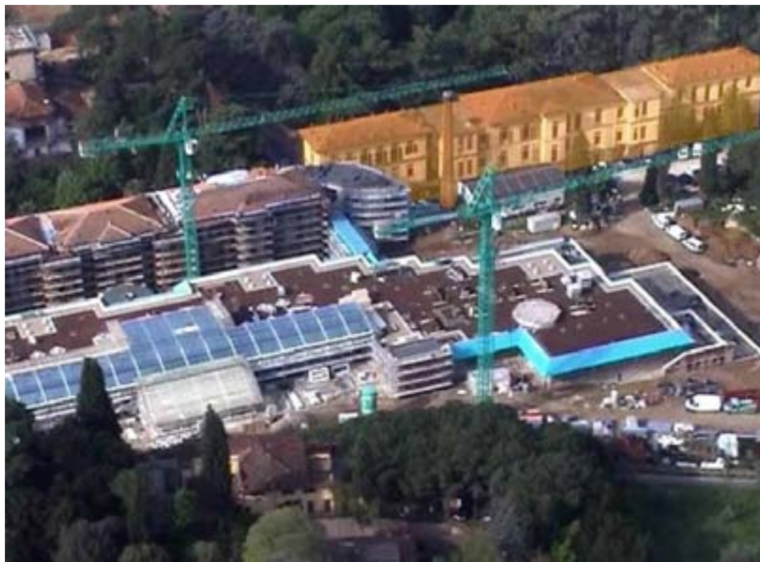
Fasi della costruzione del nuovo 'Ospedale Pediatrico Anna Meyer di Firenze
